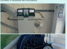
Esempio di servoscala X3 per esterni. Invece di montare la guida a parete, l'impianto può essere montato sui gradini.
